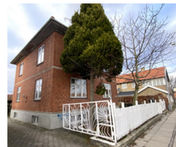
Høj sokkel og tværgående bånd i betonsten.
