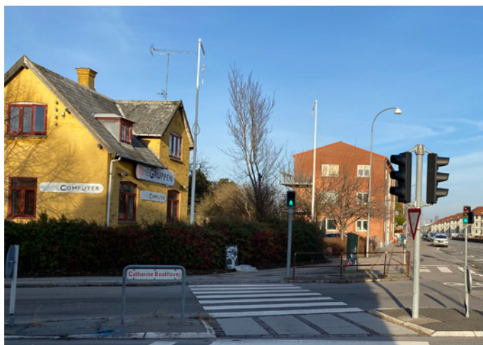
Ejendommen Gammel Køge Landevej 290 (gul bygning)
